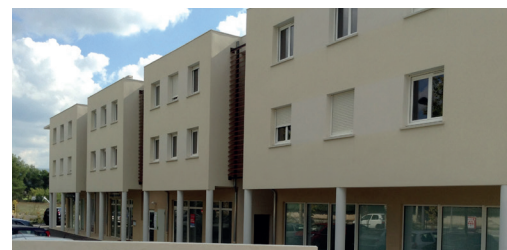
Promoteur | Villas La Provençale, Salon-de-Provence
